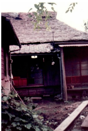
当時の我が家の北側写真、 左の建物は離れの風呂場
